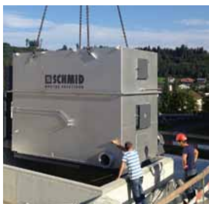
Einbau neuer Heizkessel
